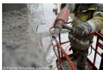
(b) Utilisation d'un piqueur sur un chantier de construction
