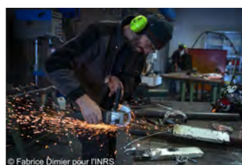
(a) Découpe d'une poutre métallique à l'aide d'une meuleuse
